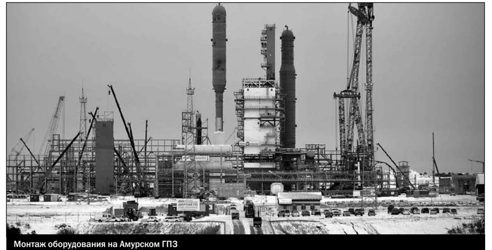
Монтаж оборудования на Амурском ГПЗ
