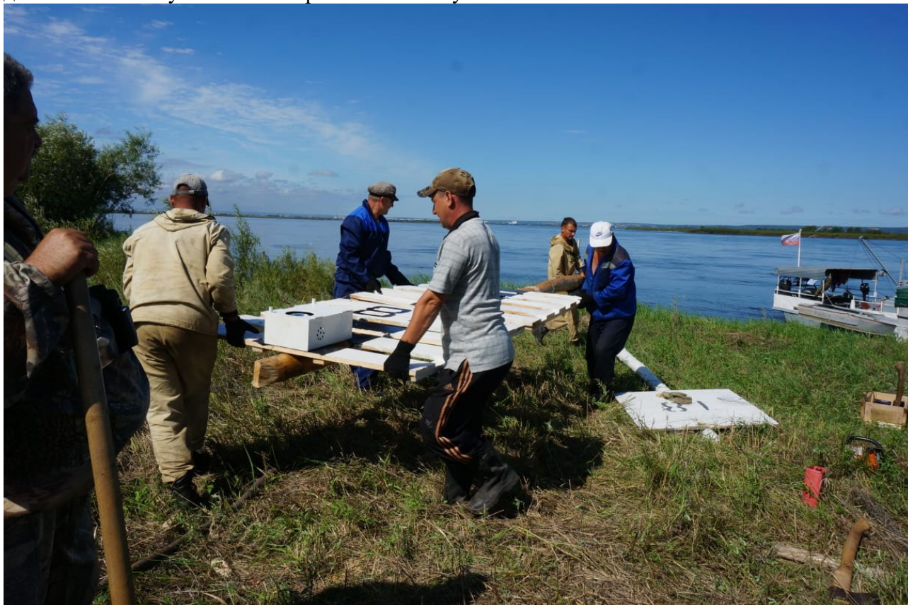
Замена створных знаков №18 первого типа 2 типоразмера на тип 1 типоразмер 8 на р. Зея
